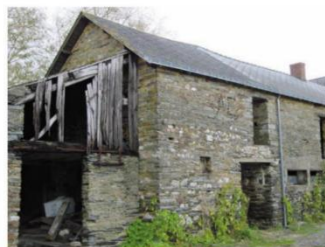
Le corps de ferme avant travaux
