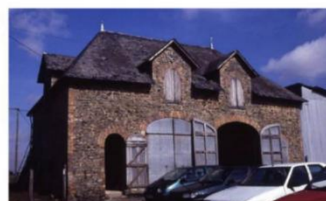
La maison avant travaux, avec sa charpente neuve reprenant le volume initial. © DR
