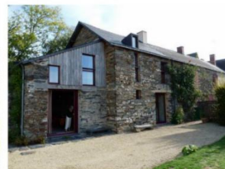
Le corps de ferme après travaux. © L'atelier Belenfant-Daubas, architectes
