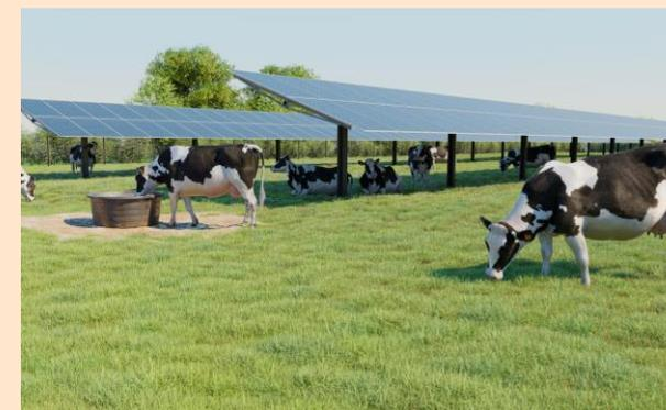
L'ombrière d'élevage permet l'atténuation des effets du changement climatique sur la prairie et sur l'élevage grâce à un ombrage tournant
